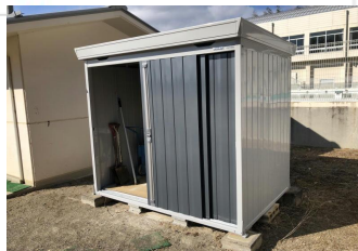
【体育倉庫の建て替え】
